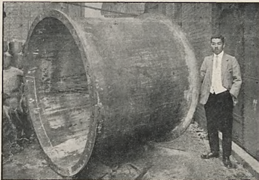
Rys. 6. Cylinder z miedzi po spawaniu.
