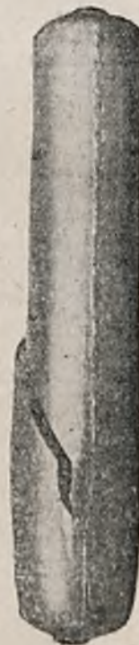
Rys. 3. Pęknięty zbiornik (kropki niewidoczne gdyż są po drugiej stronie spoiny).
