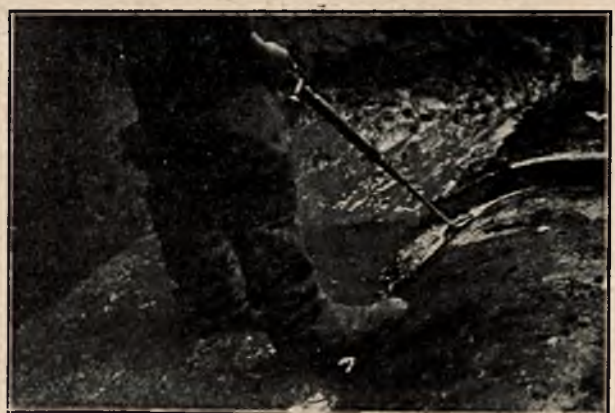
Rys. 4. Wytapianie ołowiu z kielichów rur.
