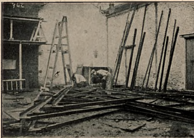
Rys. 15. Spawanie części konstrukcji dachowej na miejscu budowy.
