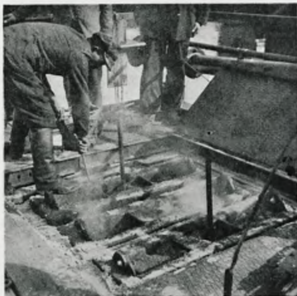
PIEC KOMOROWY DO PÓLKOKSOWANIA. USTAWIANIE RETORT.
