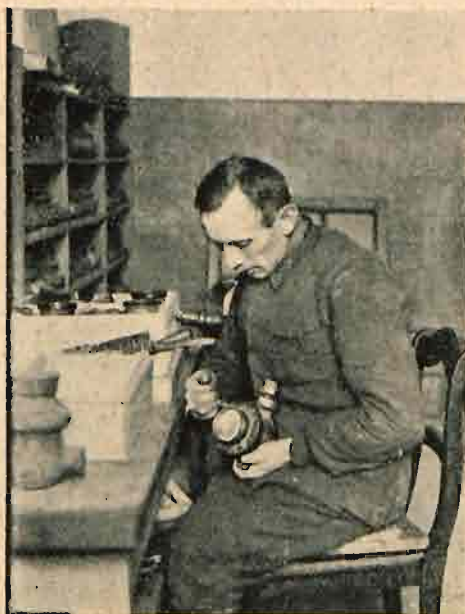
Rys. 3. Rozbieranie wodomierzy.
