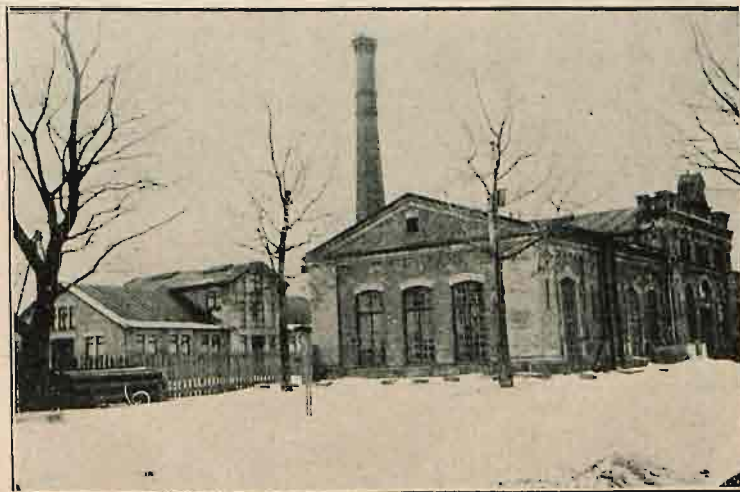
Filtry i maszynownia Stacji Pomp.
