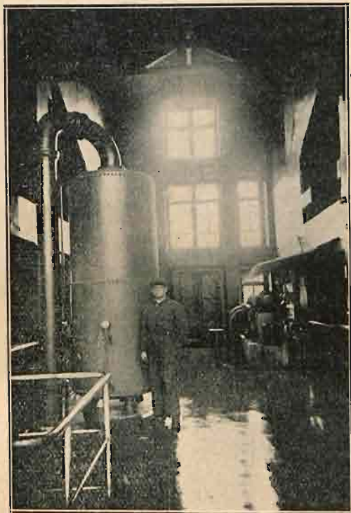
Chodnik środkowy filtrów z utleniaczem i dmuchawą do mechanicznego płukania.
