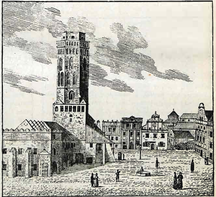
Widok rynku w Kaliszu w r. 1797 z nadziemną częścią zbiornika do wody.
