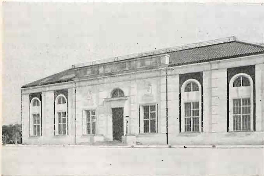
Rys. 1. Nowy Zakład filtrów pośpiesznych w Warszawie.
