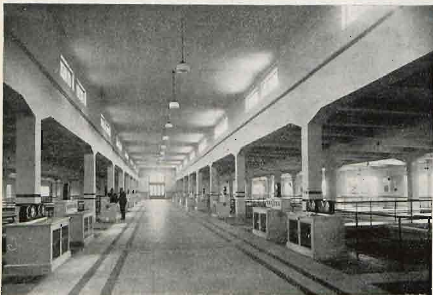
Rys. 2. Hala filtrów pośpiesznych w Warszawie.
