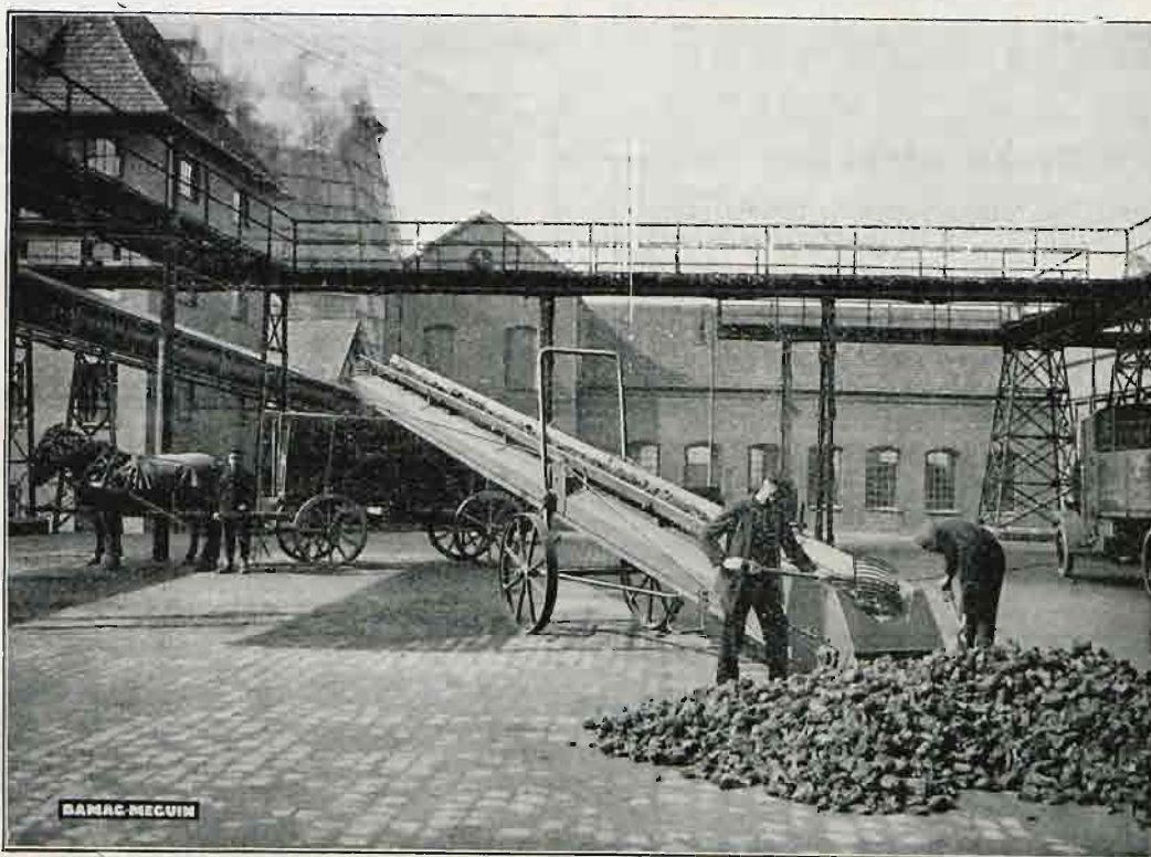
Ruchomy przenośnik taśmowy przy ładowaniu koksu w gazowni.
