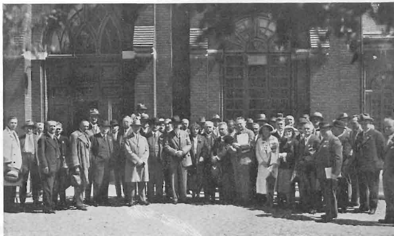
Grupa uczestników Zjazdu przed budynkiem Stacji Pomp Wodociągu m. Wilna.
