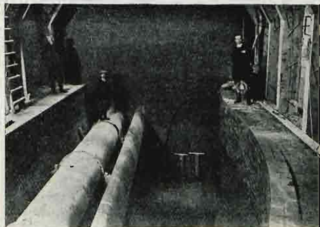
Rys. 5. Zdjęcie wybudowanego przelewu burzowego na ul. Krasińskich w Warszawie.
