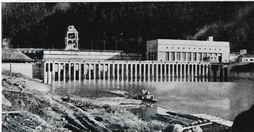
Rys. 7. Widok zakładu od dolnej wody.
