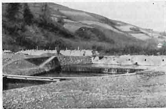
Rys. 1. Budowa zapory na pot. Mszance w dorzeczu Raby.
