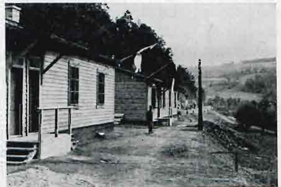
Rys. 3. Baraki biurowe Państw. Kierownictwa Budowy.
