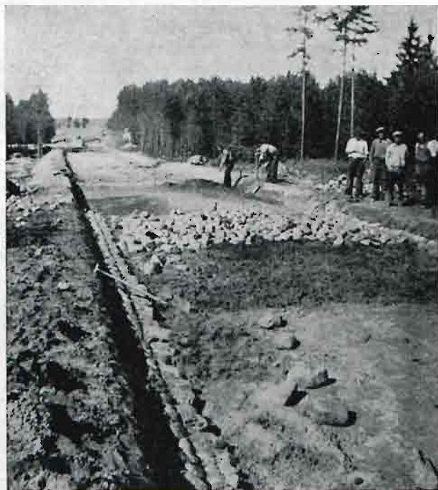
Rys. 4. Droga dojazdowa z Wilna w budowie.
