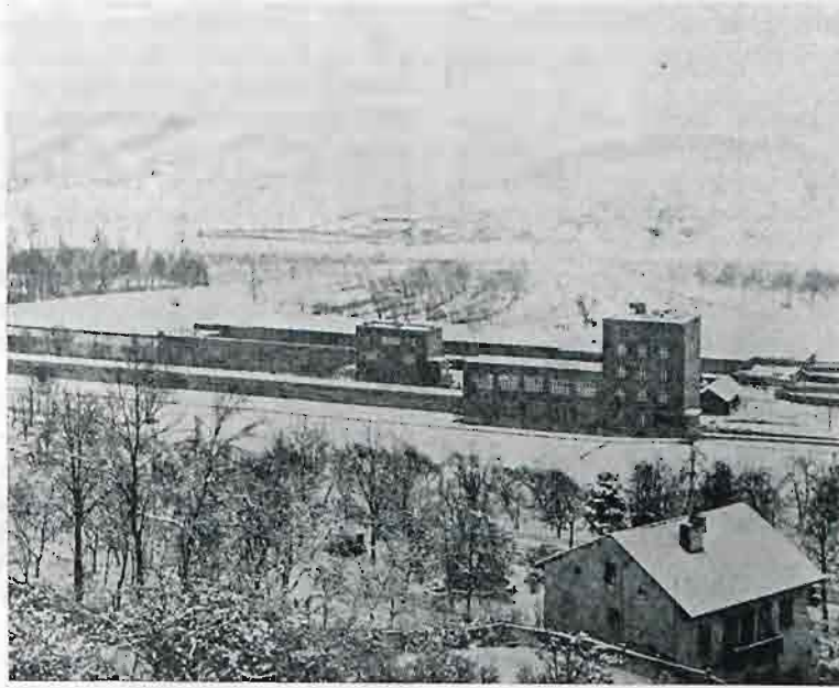
Rys. 2. Ogólny widok Instytutu Hydrotechnicznego w Pradze.
