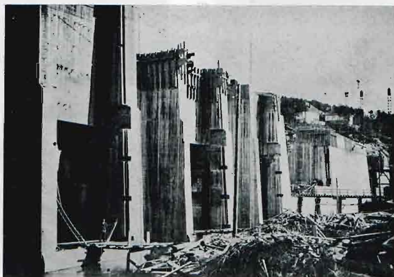
Rys. 5. Widok od strony odwodnej na wloty do turbin. Widoczne są wnętrza na kraty, ścianki zakładane i zasuwy.
