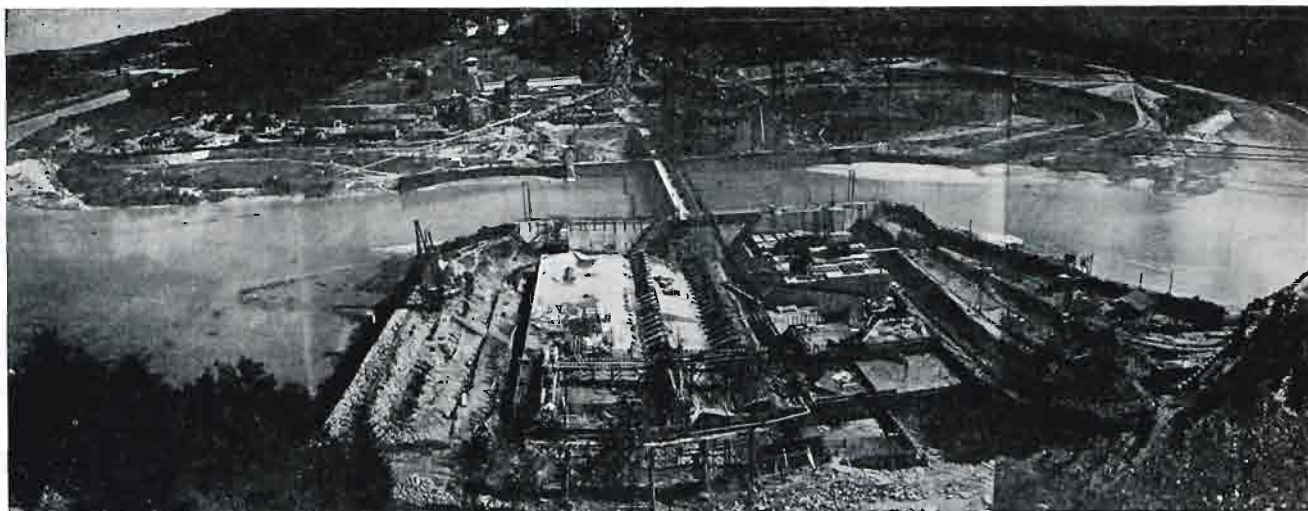
Rys. 3. Ogólny widok budowy zapory w Rożnowie. Stan 19.IX.38 r. Na pierwszym planie w obrębie grodzy budowa sekcji przelewowych z podłożem do niszczenia energii uzbrojonym 2-ma rzędami zębów, dalej kanał prowizoryczny dla przepuszczenia rzeki, za nim zakład wodno-elektryczny.
