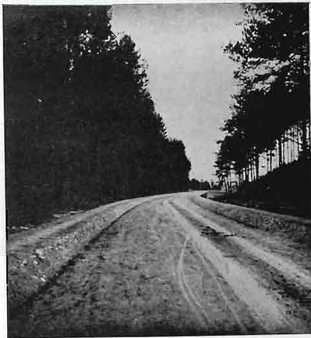
Rys. 5. Ukończona droga dojazdowa z Wilna.
