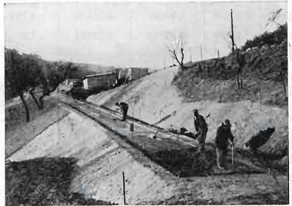
Rys. 2. Budowa drogi dojazdowej.
