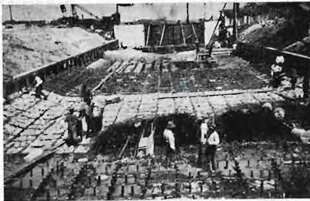
Rys. 2. Budowa śluzy w Pererubie — układanie materaca w komorze.
