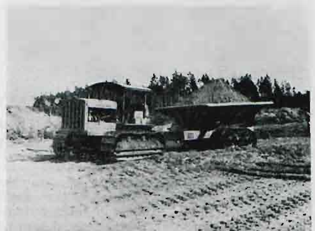
Rys. 15. Transport materiału ziemnego do budowy tamy.
