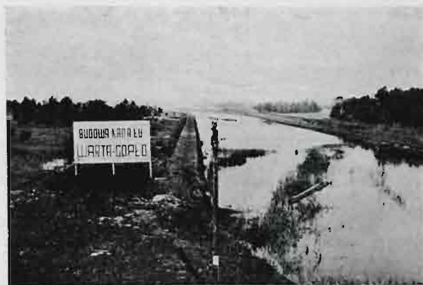
Rys. 2. Widok na odcinek kanału w okolicy Rudzicy.
