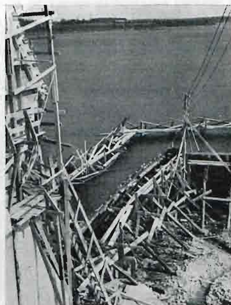
Rys. 19. Rozbierane grodze, chroniące lewobrzeżną partię wykopu.
