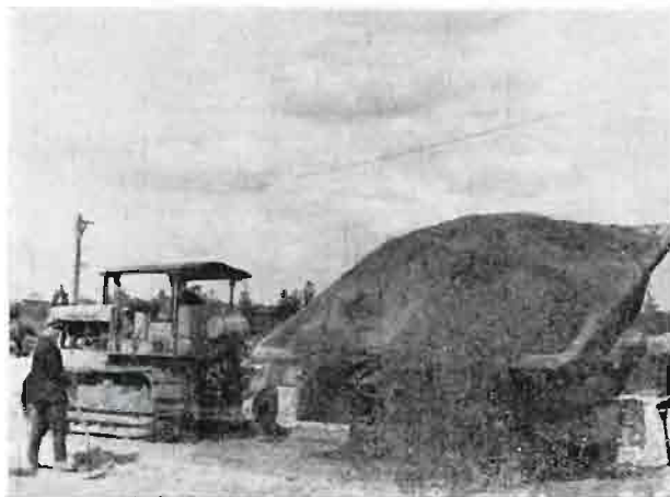
Rys. 16. Dowóz materiału ziemnego na tamę.
