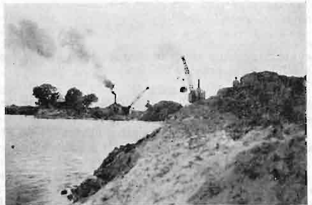
Rys. 3. Budowa śluzy w Duboi — kopanie kanału dojazdowego poniżej śluzy.
