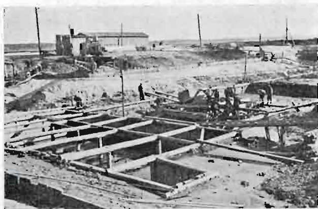
Rys. 3. Wykop fundamentowy służy Pątnowskiej. Ścianka szczelna konstrukcyjna w głowie górnej.
