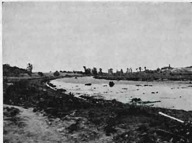
Rys. 1. Widok na odcinek kanału w okolicy Morzysławia.
