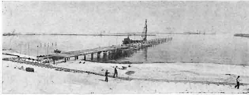
Rys. 19. Pomost żeglugi w budowie.
