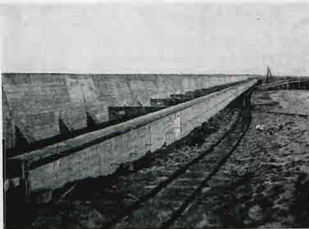
Rys. 13. Moła zachodnie — część nadwodna (gotowe parapety).
