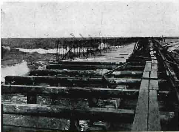
Rys. 12. Moła zachodnie — część podwodna.
