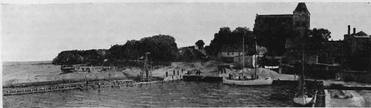
Rys. 4. Odbudowa wschodniego nabrzeża w porcie w Pucku.
