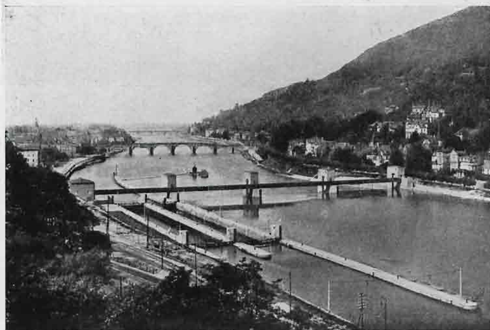
Rys. 6. Stopień kanalizacyjny w Heidelbergu. Śluza podwójna z wrotami wspornymi.
