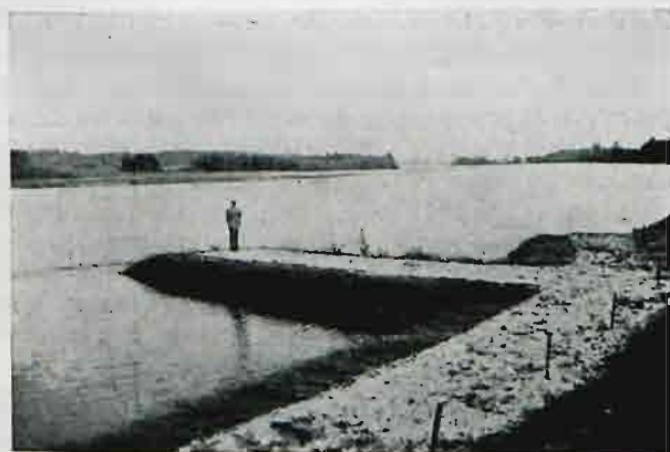
Rys. 2. Tama poprzeczna w Morzyczynie na Bugu.
