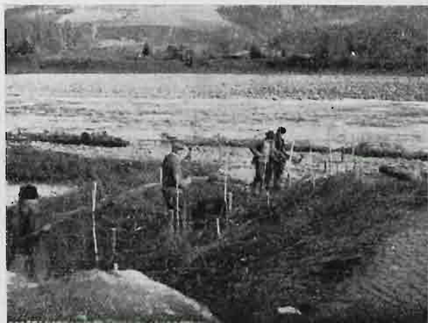
Rys. 4. Budowa poprzeczki. Widoczne pale podtrzymujące drut ankrowy.
