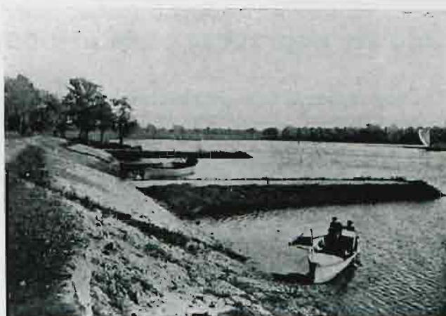
Rys. 3. Tamy poprzeczne w Bindużce na Narwi.
