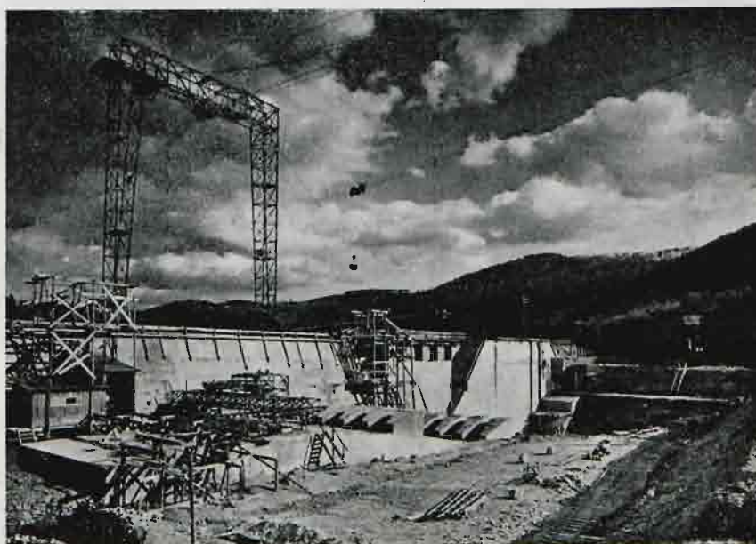
Rys. 6. Widok na podłoża do niszczenia energii (blok 12) i mur oporowy między blokami 12 i 13.
