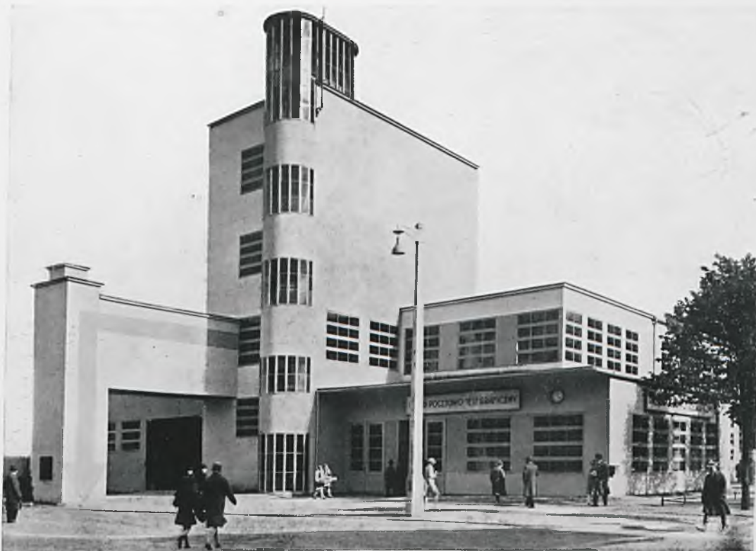
PAWILON „MINIST POCZT I TELEGR“. PROJ. INŻ. JULJAN PUTERMAN I ARCH. ANTONI MISZEWSKI Z WARSZAWY.
