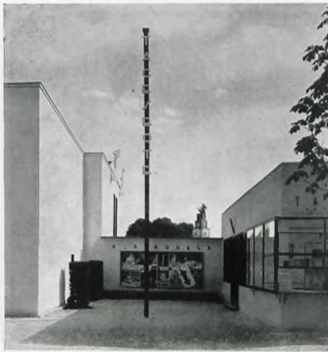
Arch. Vinzenz Baier, Berno: Podwórcze dla ogłoszeń między pawilonem „Werkbundu“, a pawilonem firmy Rudolf M. Rohrer.
