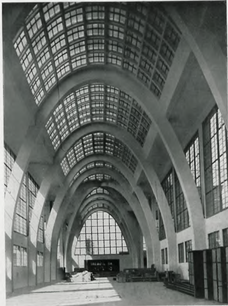
Konstrukcja łukowa w głównym pawilonie przemysłu.
