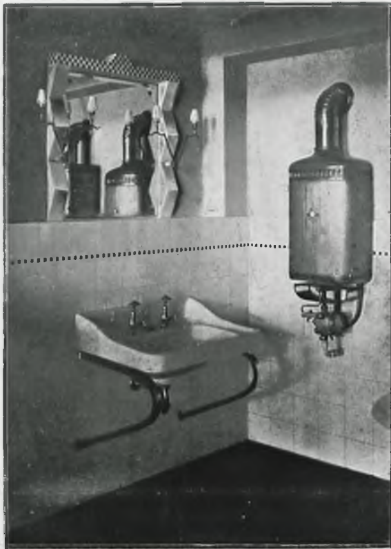
Fragment łazienki w sklepie Gazowni Miejskiej w Krakowie.
