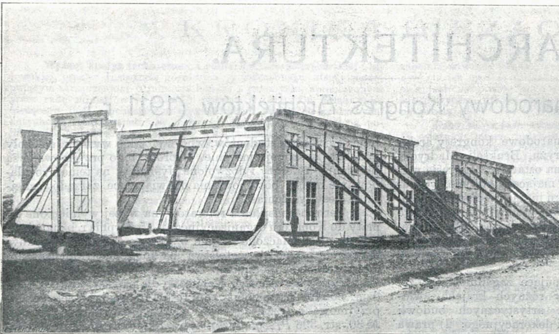
Rys. 3. Budowa koszar w Camp Pery.
