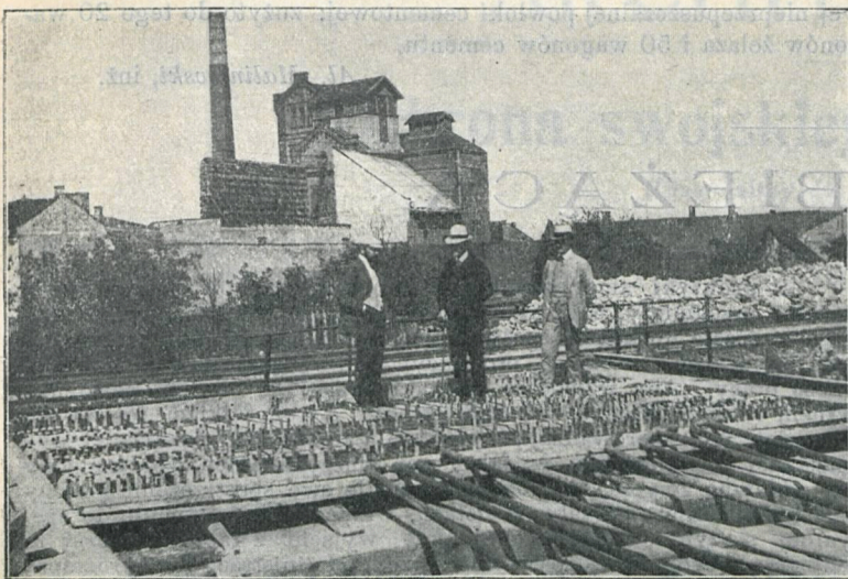
Most Akcyzowy na Podzamczu we Lwowie, wykonany w r. 1910.
