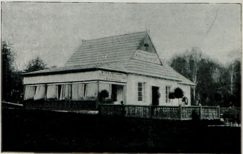
Rys. 9. Restauracja „Pod Kogutkiem“.
