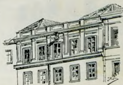
Rys. 67. Dom z dachem wklęsłym przy ul. Ś.-Jańskiej (Nr. hip. 3) w Warszawie.
