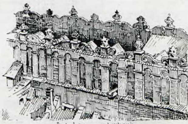
Rys. 44. Dach Sukiennic przed restauracją. (J. Matejko, 1866 r.).
