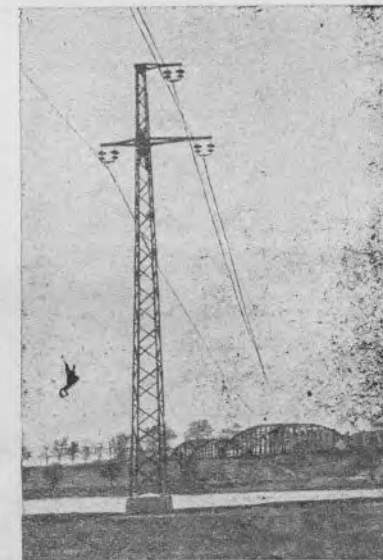
Ryc. 23. Słup linii 60000 V.
