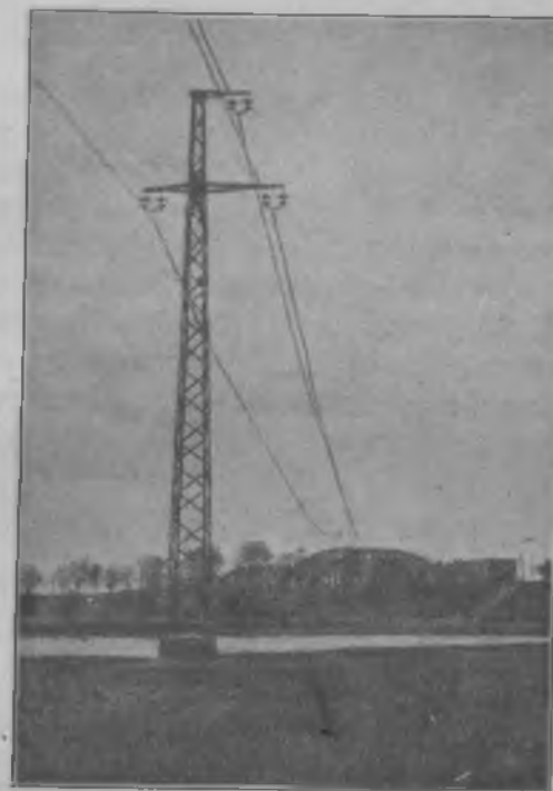
Rys. 98. Słup sieci pomorskiej na prąd trójfazowy 60000 woltów.
