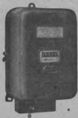
Rys. 60. Licznik, który mierzy pracę prądu w kilowatogodzinach.
