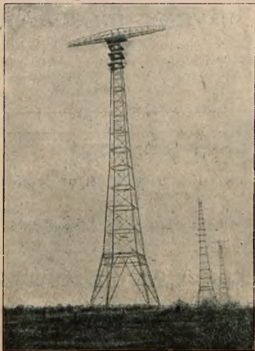
Budowa dziesięciu wież dla Transatlantycznej Radiocentrali pod Warszawą.
