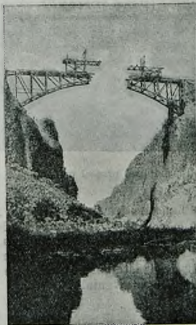
Rys. 1. Budowa mostu łukowego na rzece Crooked.
