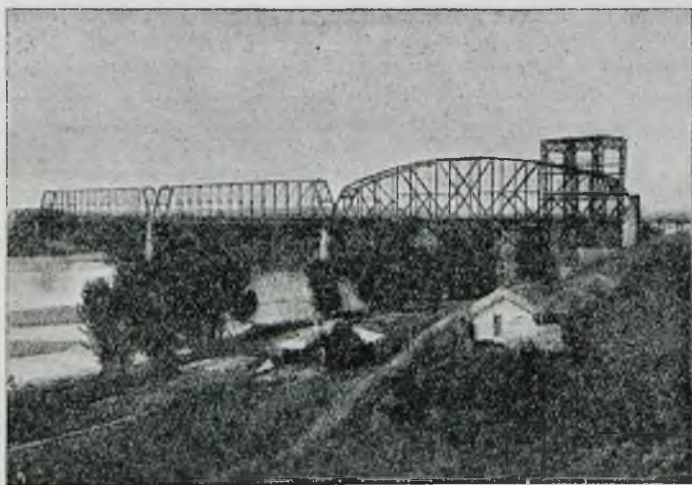
Rys. 2. Przebudowa przęseł mostu na Missouri.
