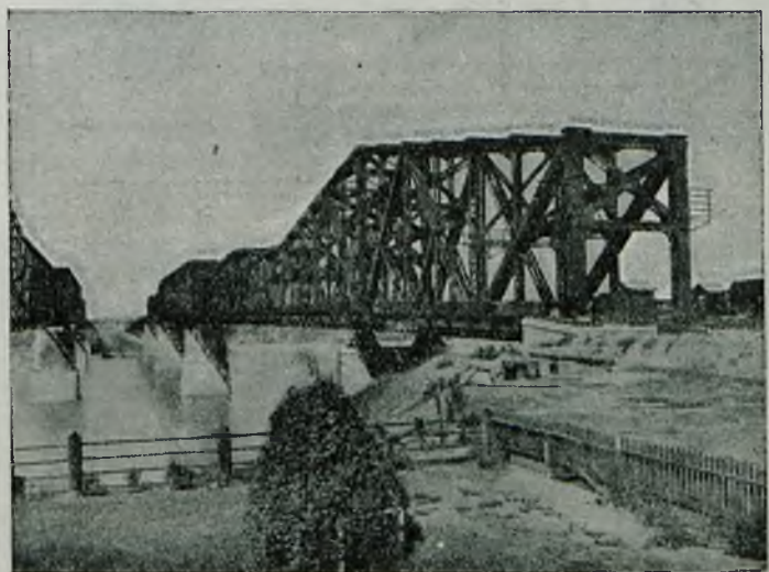
Rys. 6. Most wspornikowy Harahan pod Memphis.
