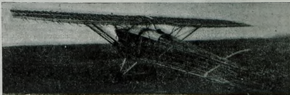
Rys. 6. Szkielet samolotu duraluminowego.
