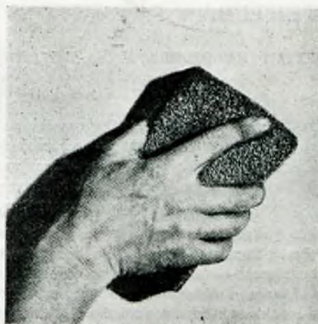
Wyprawa cementowa, grub. 6 mm., zacierana po 2 godz. od nalożenia gąbką gumową (podobno daje lepsze efekty od zwykłego zacierania).
