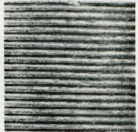
Szalowanie z nabitými latami.
