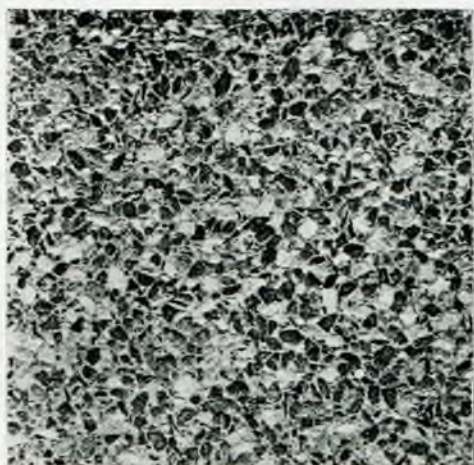
Powierzchnia zdarta szczotką drucianą w 24 godz. po betonowaniu.
