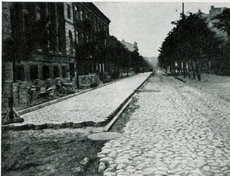
Rys. 3. Ulica Kościuszki we Włocławku. Zamiana bruku na jezdnię z płyt betonowych sześciokątnych.
