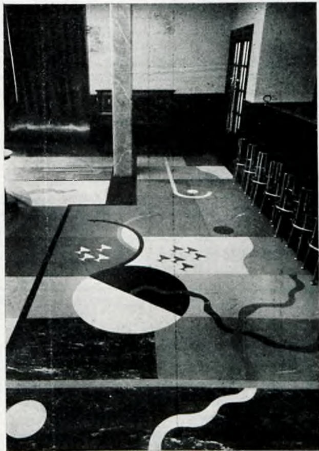
Podłogi gumowe „Ruboleum“ w palais de Danse w Poznaniu.
