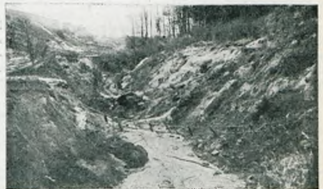
Tak wygląda glina po przejściu burzy. Tor kolejkowy wiśsi nad 20 m. przepaścią wytworzoną ulewą. Wszystkie wózki zniknęły w pobliskiej Wiśle.
