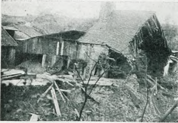
Zniszczona suszarnia i część maszynowni. Wszędzie widać szczątki maszyn, szyn i zabudowań.
