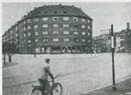
Rys. 6. Gmach w Altona kryty pierwotnie dachem płaskim, który obecnie zamieniono na stromy.
