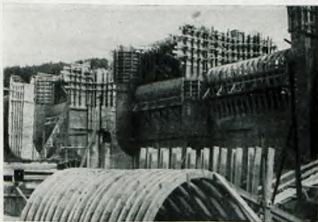
Stojaki do szalowania głowic przelewów. Pierwszy przelew zaszalowany tymi stojakami.
