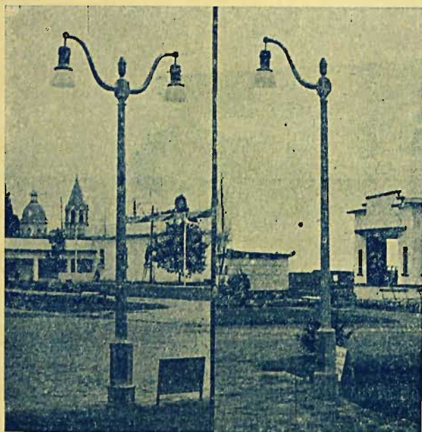
Latarnie żelbetowe na Wystawie Metalowej, wykonane na stole wibracyjnym typu „SG”.
