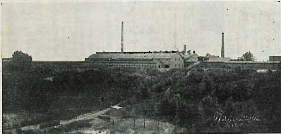
Klinkiernia Rudak. Widok ogólny ze strony glinicy.
