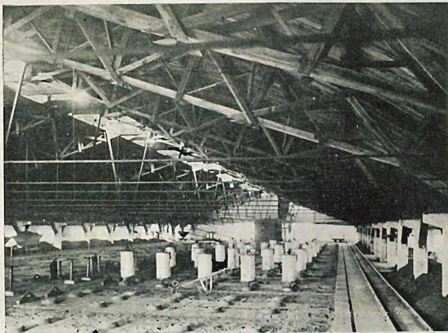
Widok pieca na górze z aparatami wysypowemi konstr. inż. Antuszewskiego i dachem syst. inż. Brody.
