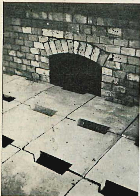
Rusztza szamotowe w komorze wypalowej pieca.
