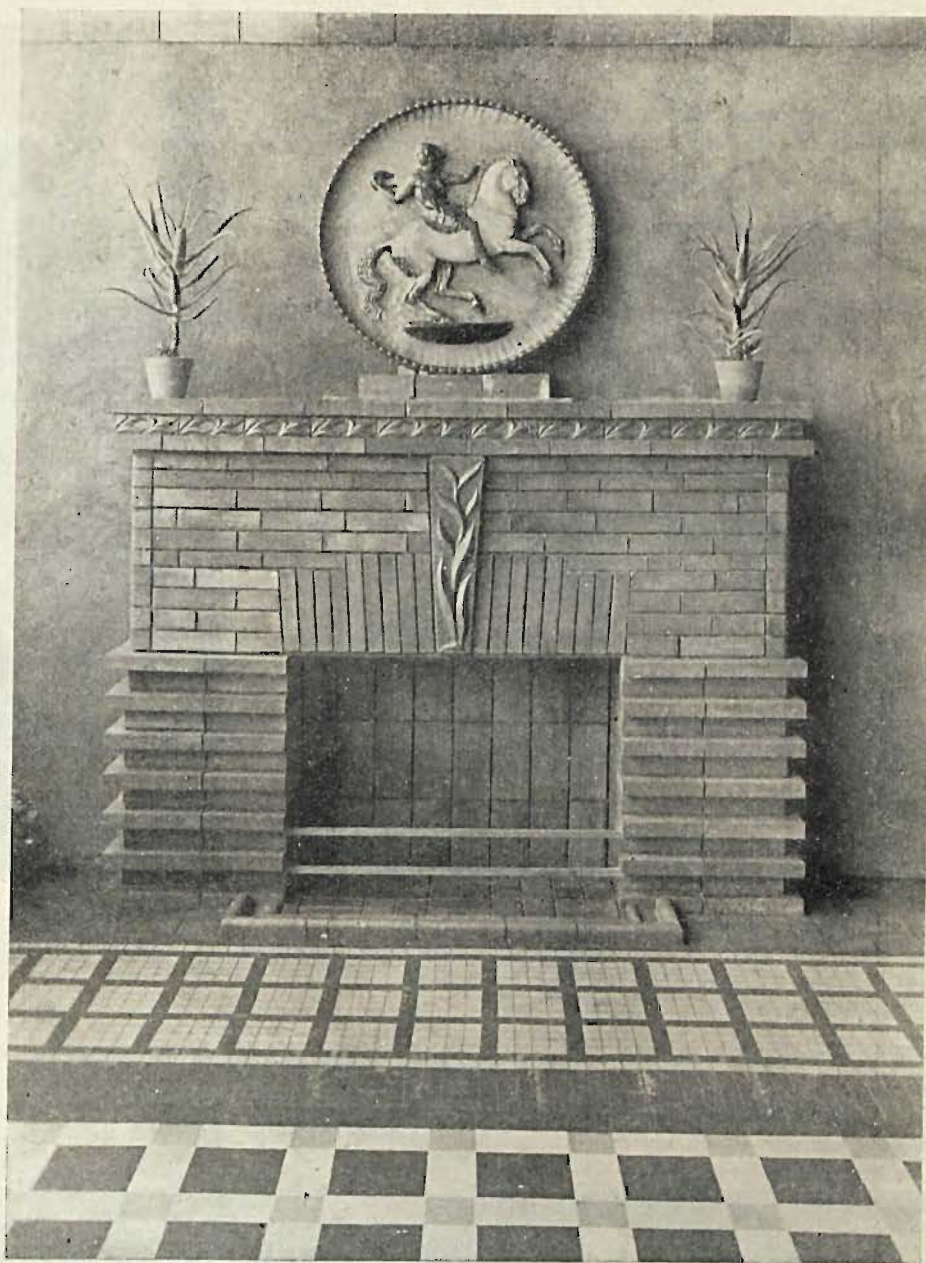
Rys. 5. Kominek obłożony barwnym klinkierem okładzinowym z Przysieki.
