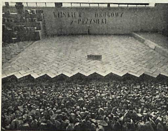
Rys. 6. Sposób ułożenia klinkieru drogowego z Przysieki.
