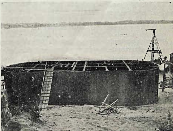
Rys. 15. Keson filara mostu na Dnieprze w Jekaterynosławiu.
