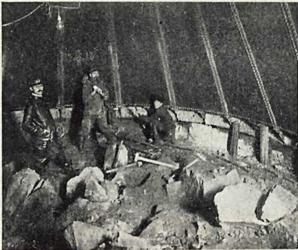
Rys. 21. Opuszczanie kesonu w skale granitowej.
