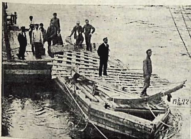
Rys. 18. Usuwanie konstrukcji zburzonego starego mostu.
