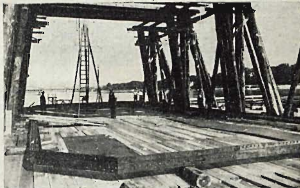
Rys. 14. Nóż kesonu żelaznego mostu drogowego na Wiśle w Toruniu.
