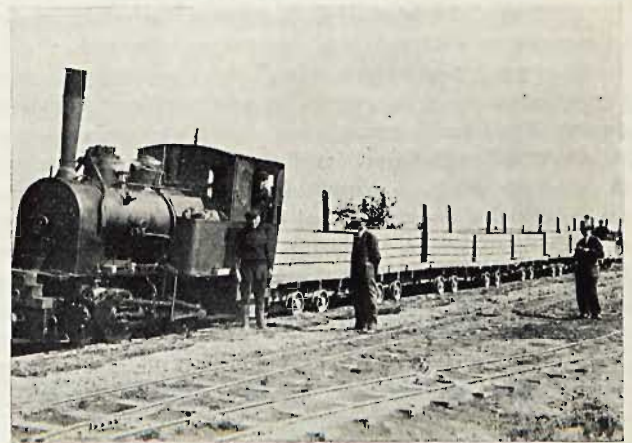
Rys. 5. Transport kolejką parową elementów żelbetowych na drodze Lubochnia — Piotrków.
