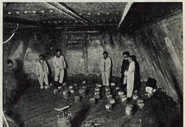
Rys. 3. Zapuszczone pale żelbetowe i zbrojenie płyty żelbetowej.
