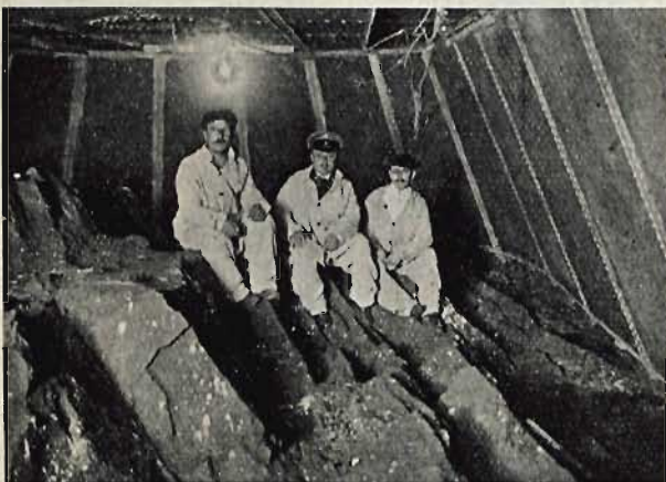
Rys. 1. Wnętrze kesonu w chwili ostatecznego posadowienia i przyjęcia dn. 24. X. 1915.
