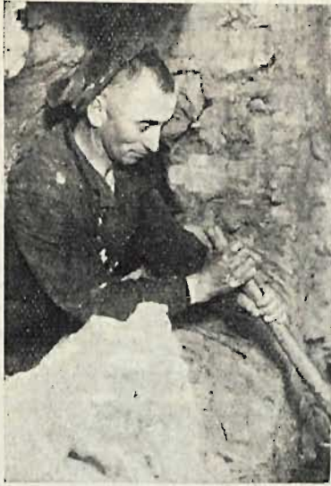
Rys. 11. Keson'arz schowany do połowy w szczelinie gruntu.
