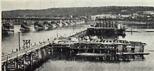
Budowa 5 filarów mostu drog. przez Wisłę we Włocławku na kesonach (1935 r.).
