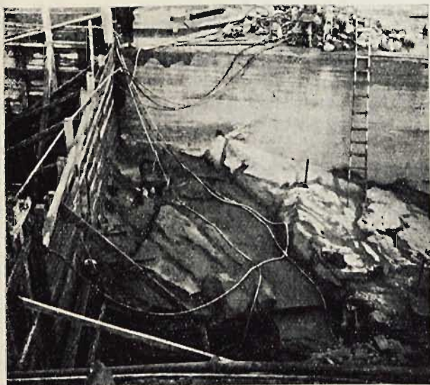
Fot. 6. Oczyszczone i zafugowane podłożo skalne przed zabetonowaniem.
