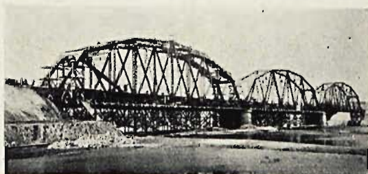
Montaż mostu kol. na rz. Pilicy linii Warszawa—Radom (1934 r.).
