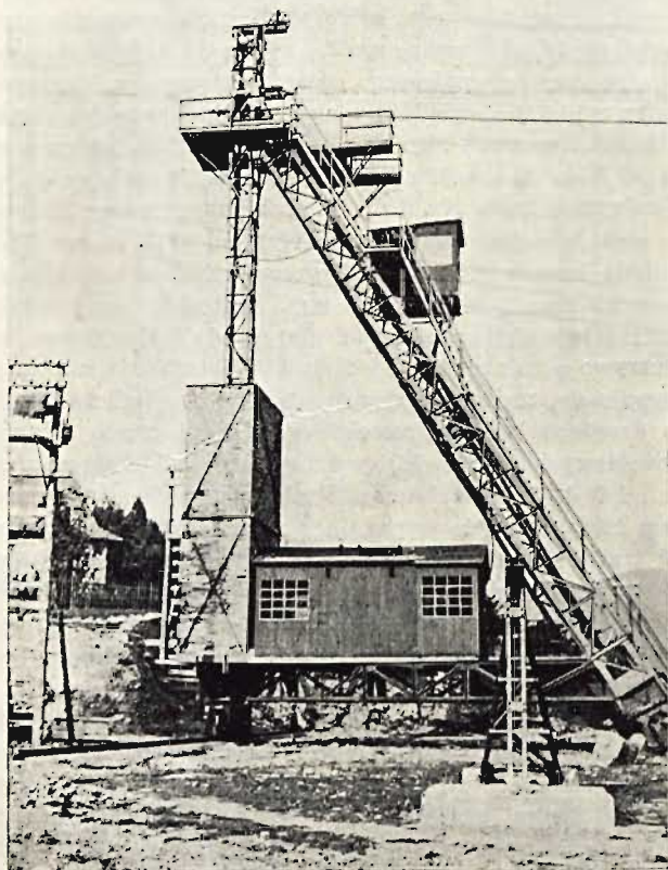
Fot. 4. Wieża maszynowa kolejki linowej.
