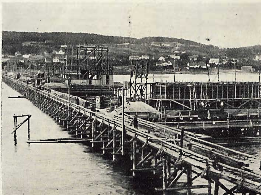
Widok ogólny robót.
