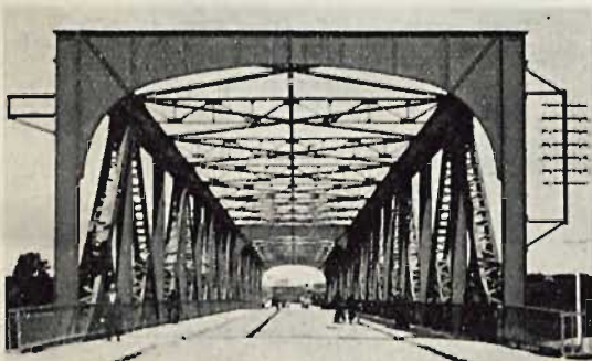
Montaż mostu drog. na zalewie rz. Warty pod Czarkowem w Koninie (1932 r.).
