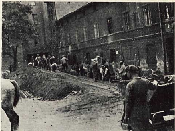
Rys. 4. Fragment magazynowania i wywozu ziemi na sąsiednim podwórku.
