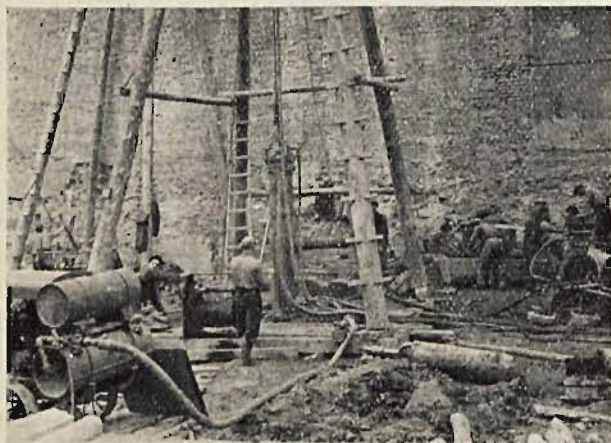
Rys. 9. Fragment betonowania pala widoczna rura usuwana z otworu podczas betonowania, kompresor i inżektor.
