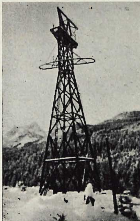
Rys. 8. Wieża podporowa konstrukcji stalowej.
