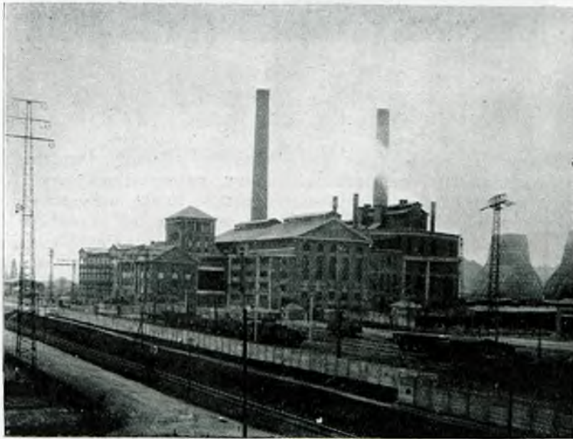
Rys. 1. Widok ogólny elektrowni.
