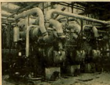
Stacja destylacyjna o wydajności 8000 litr./godz., ustawiona na szybie Carmer S. A. Giesche w Nikiszowcu, Górny Śląsk
