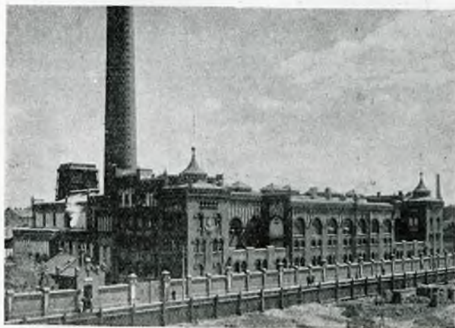
Rys. 1. Widok ogólny elektrowni.
