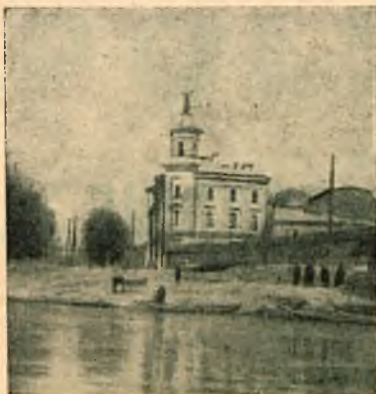
Widok elektrowni w Wilnie.
