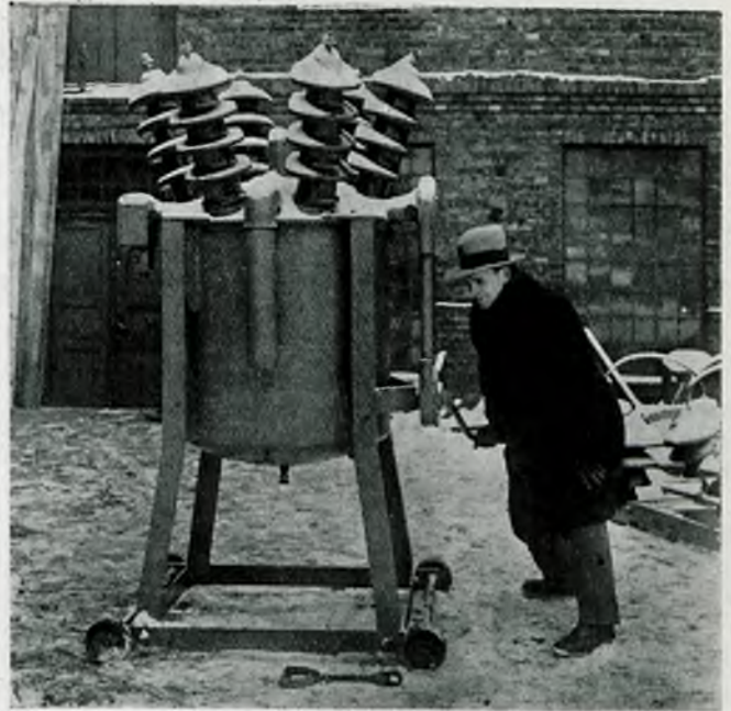
Wyłączniki olejowe samoczynne. Typ do 10 kV oraz typ dla dużych mocy zwarcia do 35 kV. Pokrywa i zbiornik — prasowana gruba blacha. Izolatory — rozmieszczone koncentrycznie. Kontakty — wtykowe koncentryczne. Części uziemione — usunięte z wnętrza całkowicie. Zamek — nieskompilowany i pewny. Sprężyna wyłączająca — centralna, jedyna, niezawodna.
