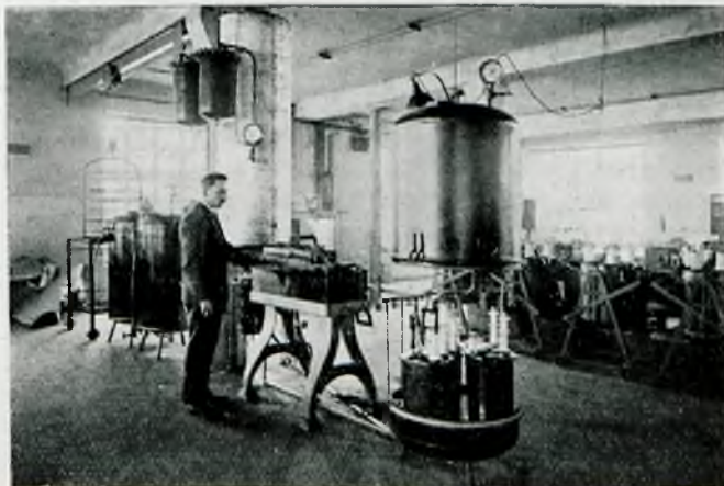
Urządzenie do oczyszczania i napełniania olejem gotowych transformatorów.
