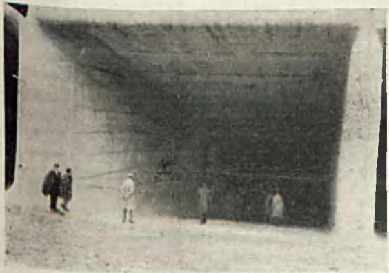
Rys. 7. Ryburg — Schwörstadt Wylot kanału turbiny
