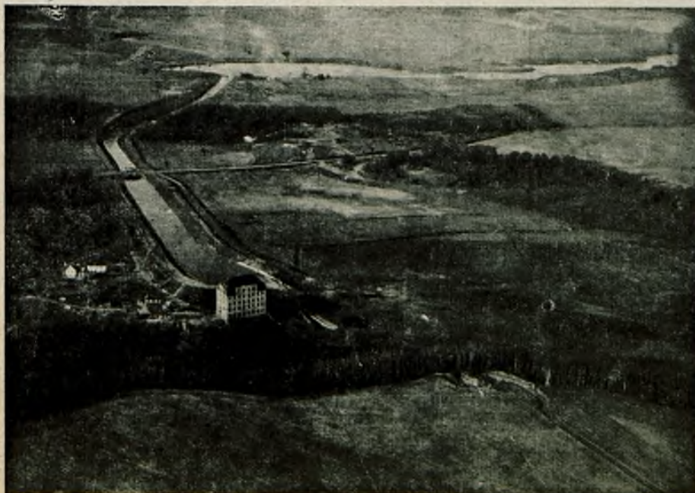
Rys. 3. „Gródek”. Widok zakładu z lotu ptaka.
