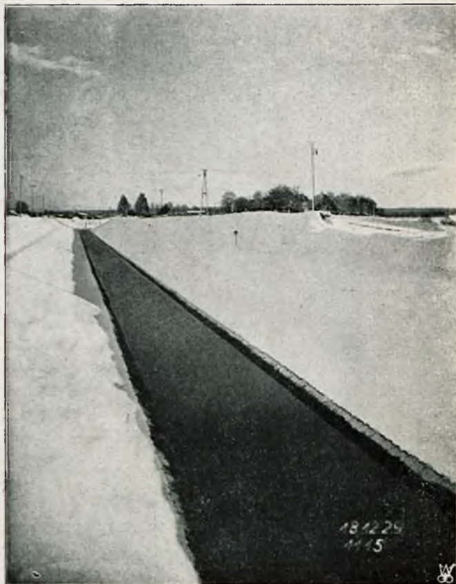
Rys. 11. Kanał roboczy o przełyku 75 m 3 /sek.
