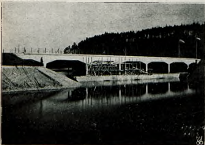
Rys. 10. Żelbetowy most nad zalanym mostem murowanym w Tleniu, (17.XII.29).
