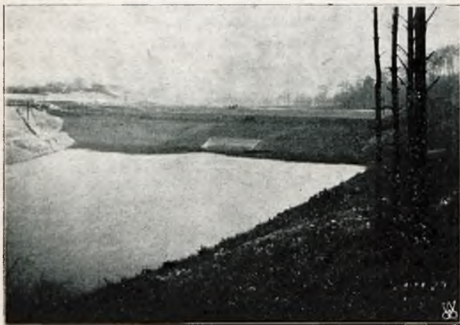
Rys. 9. Zapora i zbiornik (21.XI.29). (Poziom wody podniesie się jeszcze o 10 m).
