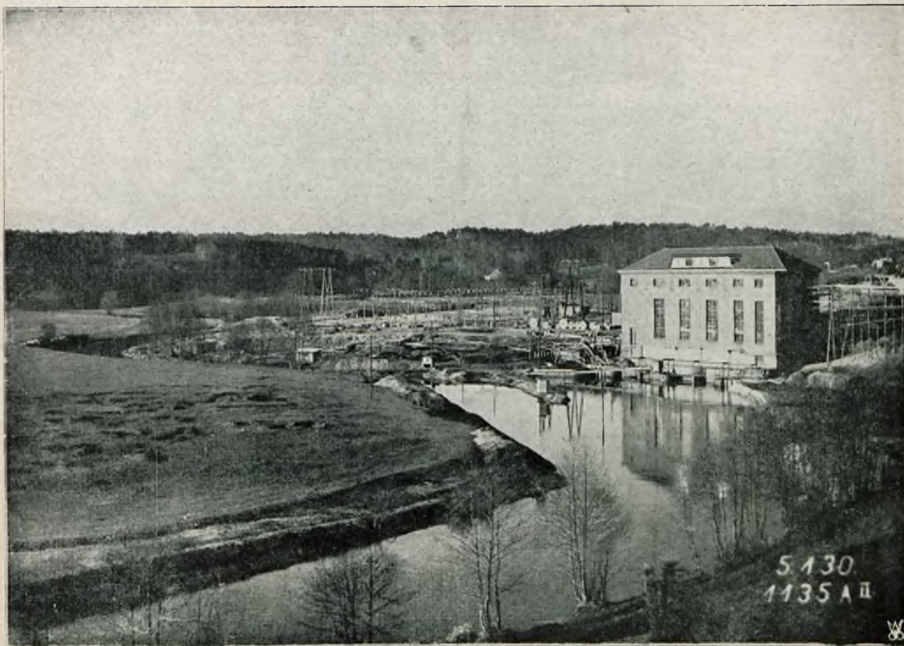
Rys. 17. Hala maszyn i rozdzielnia pod gołym niebem.
