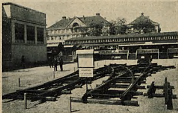
Rys. 1. Rozjazd wykonany z szyn Zakładów Ostrowieckich. Lwowskich i Łódzkich, Zakłady przeprowadziły odbudowę zniszczonej walcowni szyn.
