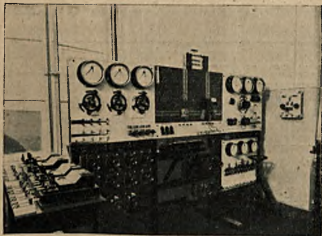
Rys. 11. Mała tablica miernicza prądu trójfazowego.
