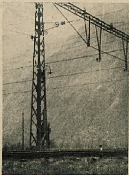
Rys. 5. Przeciwwaga dla regulacji sieci roboczej.
