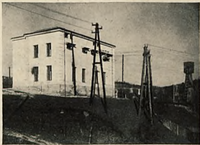
Stacja transformatorowa 15/3 kV w Mrażnicy, własność Podk. Tow. El.
