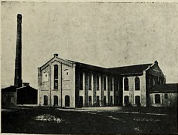
Zychlin. Główny budynek fabryczny.
