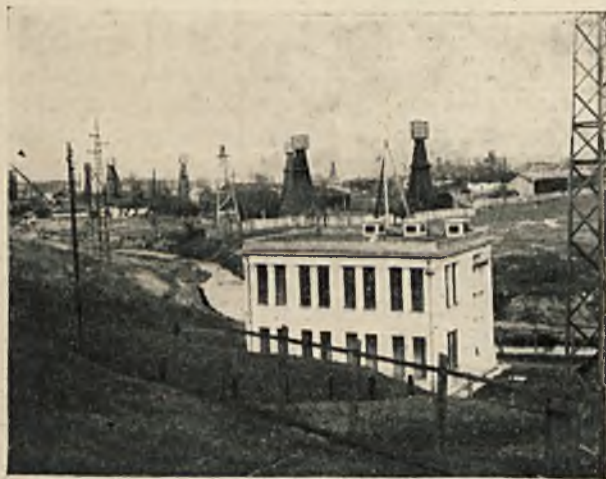
Stacja Transformatorowa 35/3 kV w Boryslawiu, własność „Galicii”.
