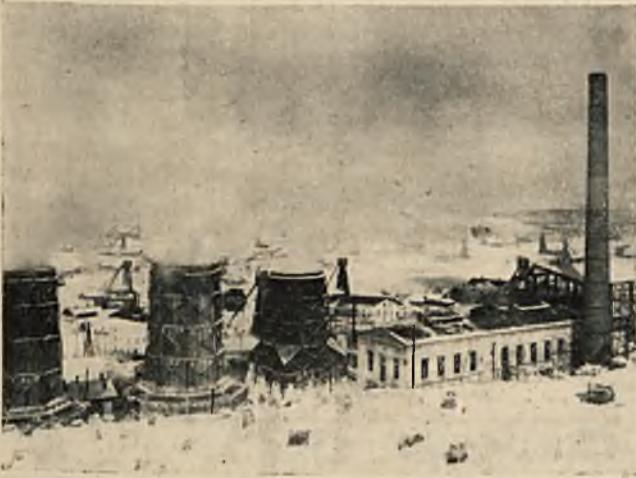
Widok ogólny elektrowni Sp. Akc. Premier.
