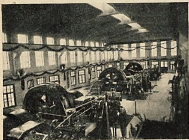
Hala maszyn elektrowni Zagłębia Krośnieńskiego w Brzeźowce.
