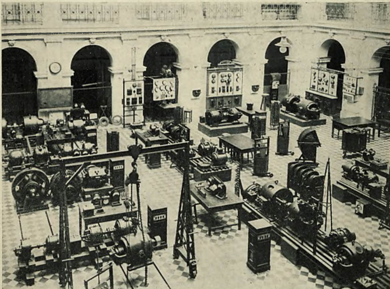
Pracownia maszyn elektrycznych Politechniki Warszawskiej.
