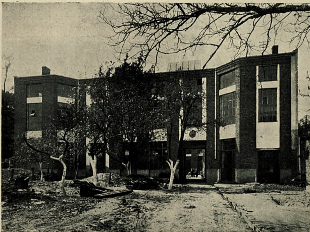
Nowowytbudowana fabryka przy ulicy Okopowej Nr. 19 (na ukończeniu).
