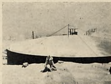
Piorunochron na zbiorniku do ropy o pojemności 4000 m 3 .
