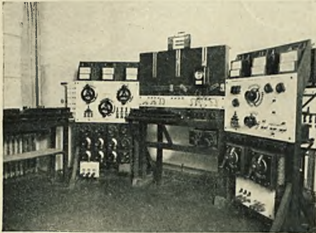
Duża tablica rozdzielcza prądu trójfazowego.
