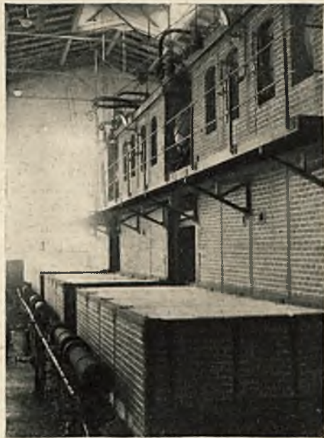
Kotłownia elektrowni Sp. Akc. Premier.
