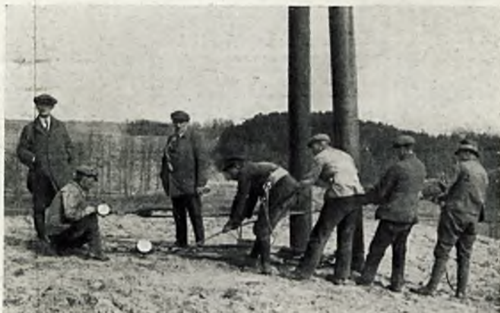
Rys. 25. Naciąganie przewodów za pomocą wielokrążków i dynamometrów, 1925.
