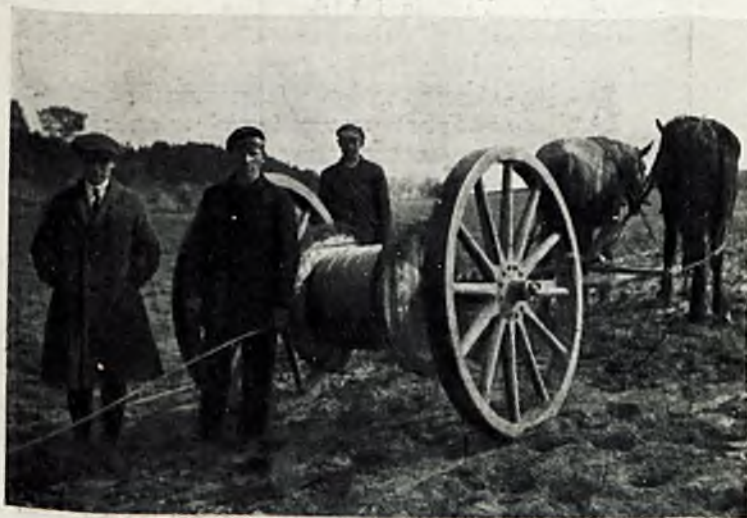
Rys. 24 Rozwożenie linki końmi i wozem 1-osiowym („armatą”). Linia Gródek — Grudziądz, 1925.
