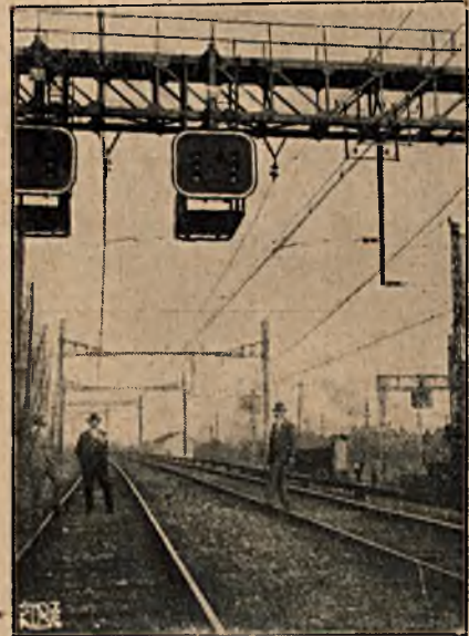
Fig. 4. Automataczne sygnały świetlne na linii Paris — Orléans.
