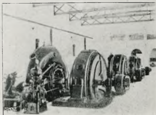
Rys. 25. Widok hali elektrowni z turbinami wodnymi o wale poziomym.
